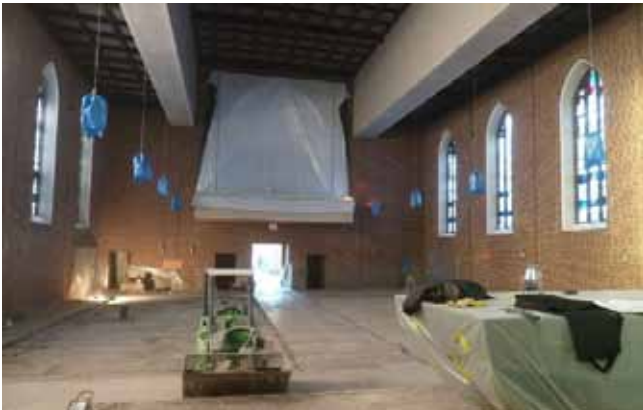
Blick in die Kirche während der Bauarbeiten Foto: Rolf Rörig
